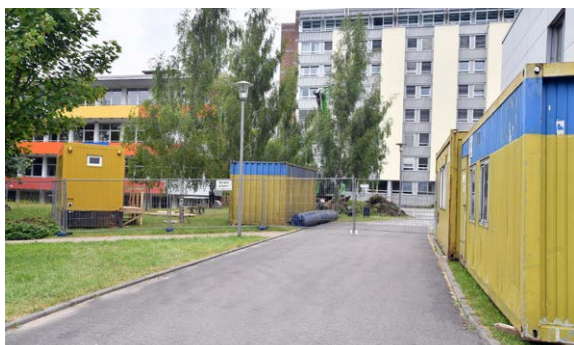
Bagger, Bauzäune und Absperungen – es ist unübersehbar, dass es bald richtig losgeht.
